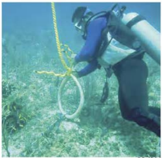
Un plongeur occupé à fixer une amarre permanente afin de freiner la détérioration du site par l'amarrage des bateaux.
